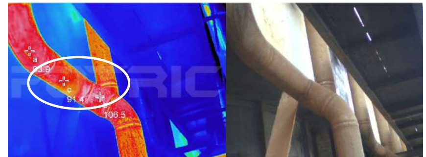
正常的顶循管道
